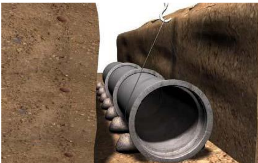
Figura 12 - Alinhamentos dos tubos com apoio de calços
