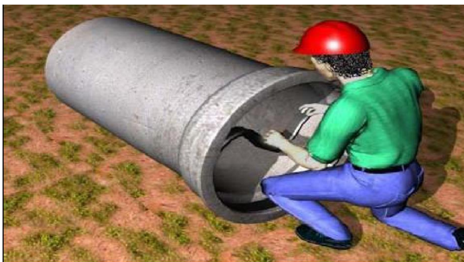
Figura 106 - Colocação do anel de borracha
